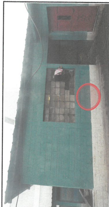
Foto 5: Área de colocación de pedestales de concreto y remozamiento de puerta de metal, mediante pintura anticorrosiva y cambio de lámina.
